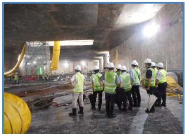
ノースサウスコリドー現場見学
