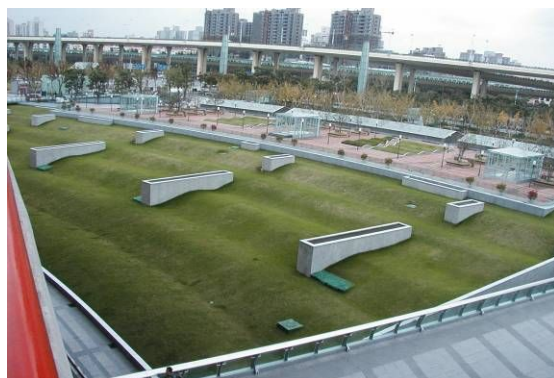
上海南駅前地下駐車場、地下街の上部
