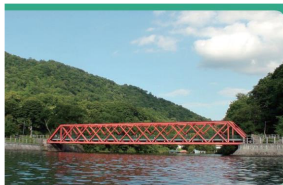
2018 年度選奨土木遺産 山線鉄橋 (北海道・明治 32 年竣工)
