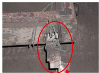
トンネル照明取付金具の腐食による脱落の危険性 (針金番線による応急措置)
