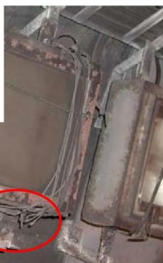
トンネル照明取付金具の腐食による脱落の危険性 (針金番線による応急措置)
