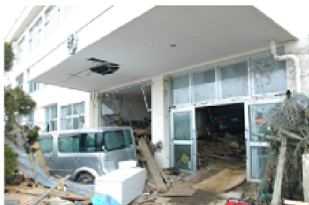
被災時の校舎（1階天井近くまで浸水）
