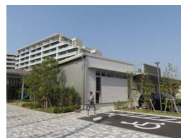
④辻堂西口YU-ZUルームの外観
