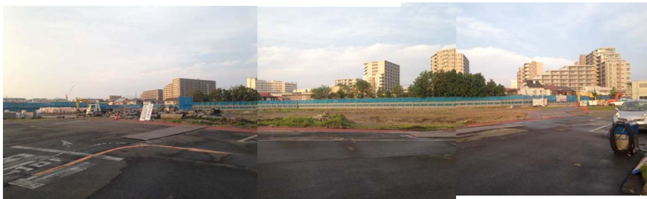
①地区内から地区北東側を眺めた風景 (基盤整備工事中)
