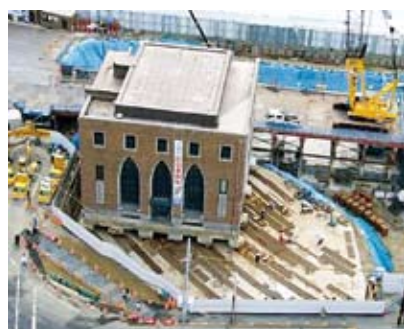
約20mの移築完了
