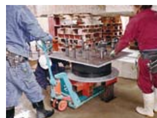
免震装置の取り付け
