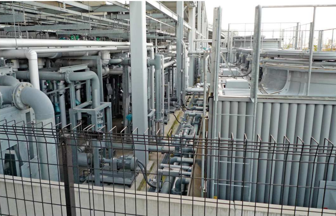
下水再生水熱利用システム
