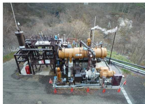
まちづくりの柱としてスタートしたバイナリー発電設備
